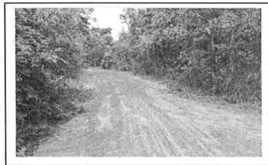
กม. ๐+๔๐๐ (สภาพสายทางโดยทั่วไป)
