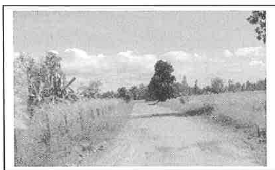
กม. ๒+๖๐๐ (สภาพสายทางโดยทั่วไป)
