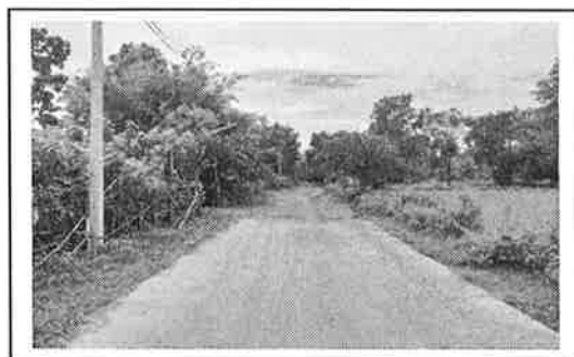
กม. ๐+๓๔๗ (สภาพสายทางโดยทั่วไป)
