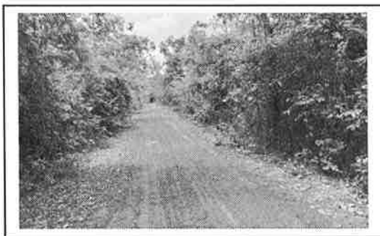
กม. ๐+๗๐๐ (สภาพสายทางโดยทั่วไป)
