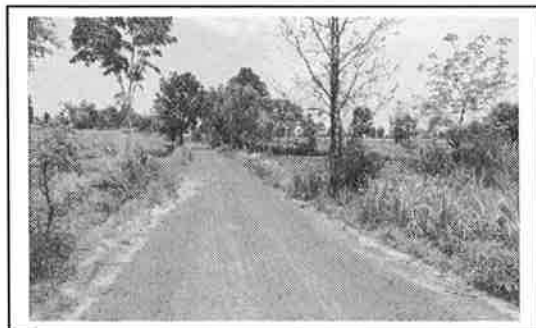
กม. ๒+๐๐๐ (สภาพสายทางโดยทั่วไป)
