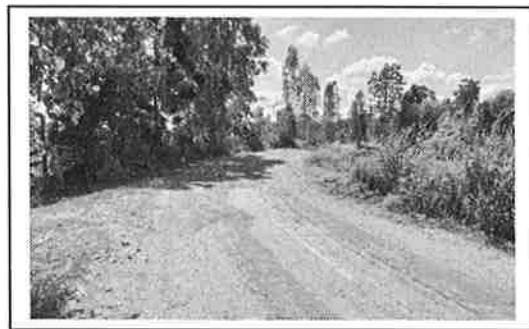
กม. ๐+๒๕๐ (สภาพสายทางโดยทั่วไป)
