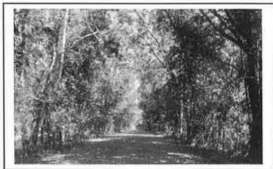
กม. ๐±๕๐๐ (สภาพสายทางโดยทั่วไป)
