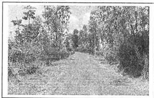
กม. ๐+๒๐๐ (สภาพสายทางโดยทั่วไป)
