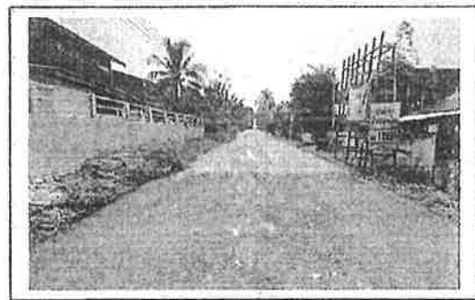
กม. ๐+๑๑๐ (สภาพสายทางโดยทั่วไป)
