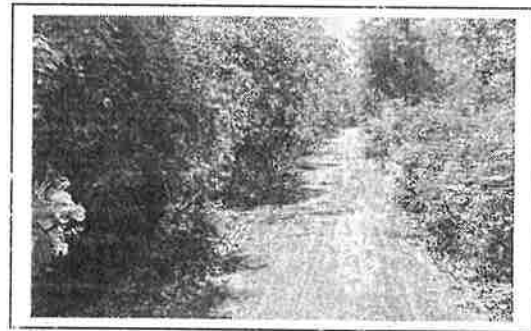
กม. ๐+๓๐๐ (สภาพสายทางโดยทั่วไป)
