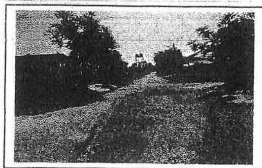
กม. ๐+๓๕๐ (สภาพสายทางโดยทั่วไป)
