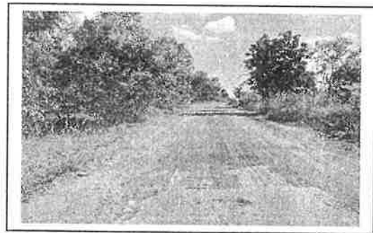
กม. ๐+๔๐๐ (สภาพสายทางโดยทั่วไป)
