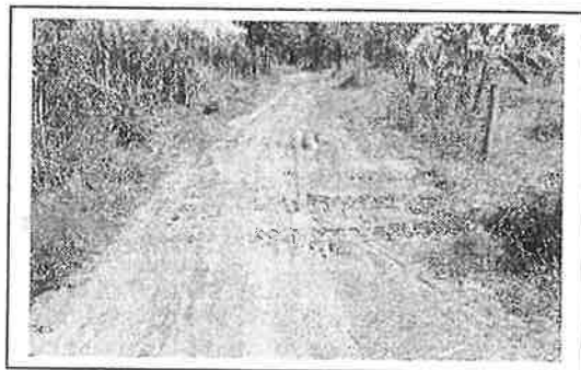
กม. ๒+๐๐๐ (สภาพสายทางโดยทั่วไป)
