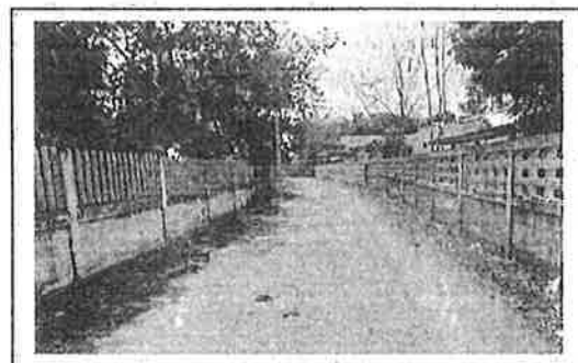
กม. ๐+๐๒๐ (สภาพสายทางโดยทั่วไป)
