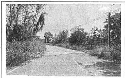
กม. ๐+๓๒๐ (สภาพสายทางโดยทั่วไป)
