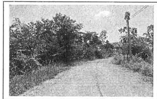
กม. ๐+๔๕๕ (สภาพสายทางโดยทั่วไป)
