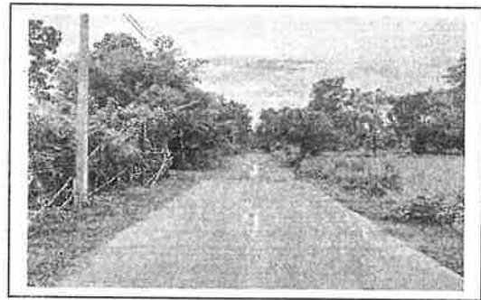
กม. ๐+๓๕๗ (สภาพสายทางโดยทั่วไป)
