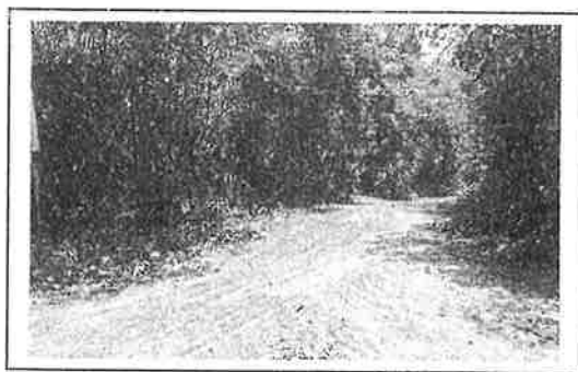
กม. ๐+๕๐๐ (สภาพสายทางโดยทั่วไป)
