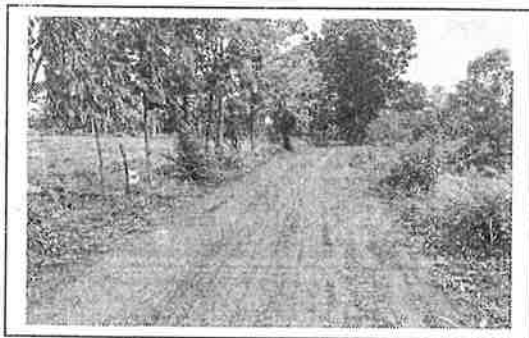
กม. ๐+๖๐๐ (สภาพสายทางโดยทั่วไป)
