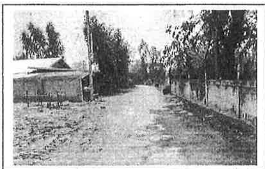
กม. ๐+๑๓๐ (สภาพสายทางโดยทั่วไป)
