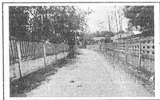
กม. ๑๕๑๑ (สภาพสายทางโดยทั่วไป)
