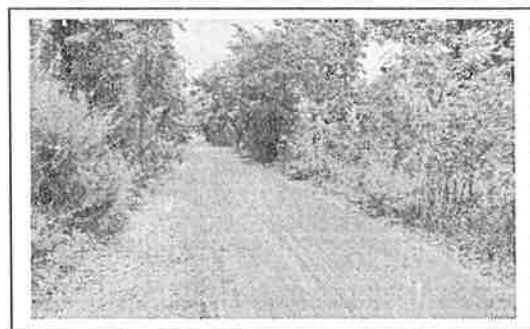
กม. ๑๕๐๐๐ (สภาพสายทางโดยทั่วไป)
