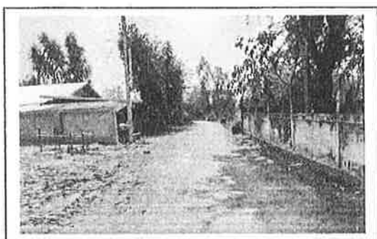
กม. ๑๕๓๐. (สภาพสายทางโดยทั่วไป)
