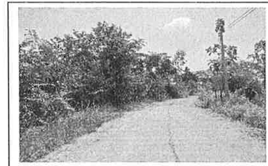
กม. ๐+๔๘๐ (สภาพสายทางโดยทั่วไป)
