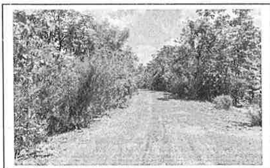
กม. ๐+๘๐๐ (สภาพสายทางโดยทั่วไป)
