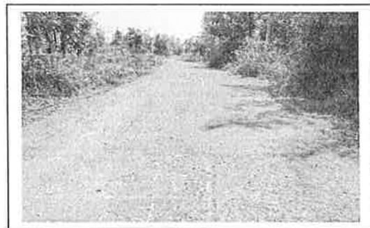
กม. ๐+๑๒๕ (สภาพสายทางโดยทั่วไป)
